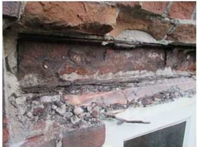
Afbeelding 1: Gecorrodeerde gevellatei
