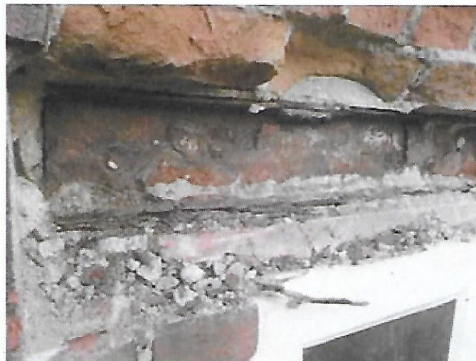
Afbeelding 1: Gecorrodeerde gevellatei
